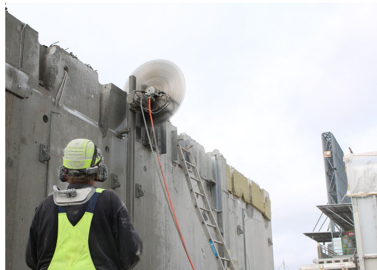
Nedrivning af betonelementer. Foto: IKEA
