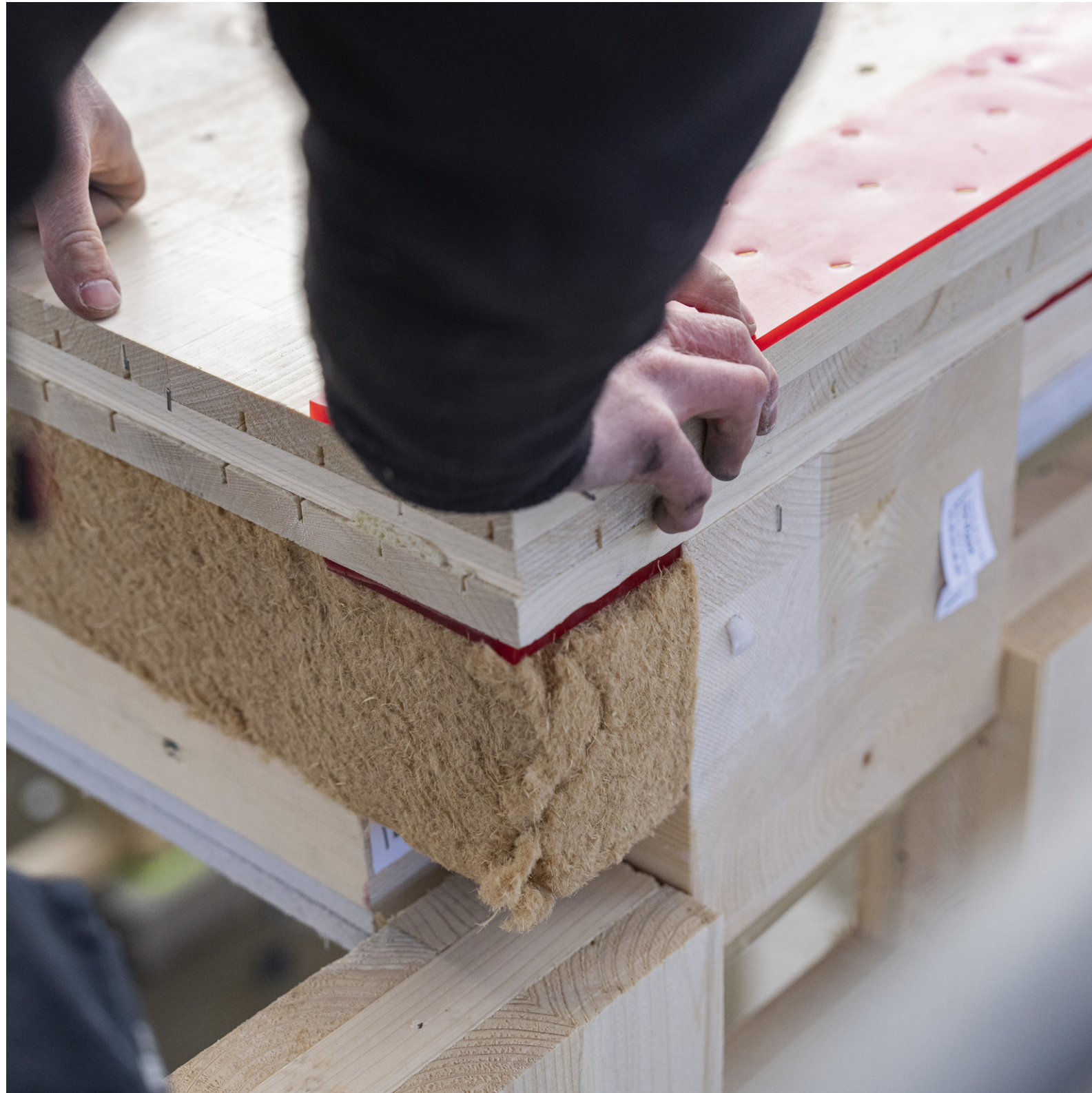
Etagedæk udviklet i forbindelse med Realdania By & Bygs udviklingsbyggeri MiniCO2 Etagehus TRÆ.
