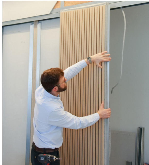
Montering af den cirkulære skillevæg. Foto: ERIK arkitekter
