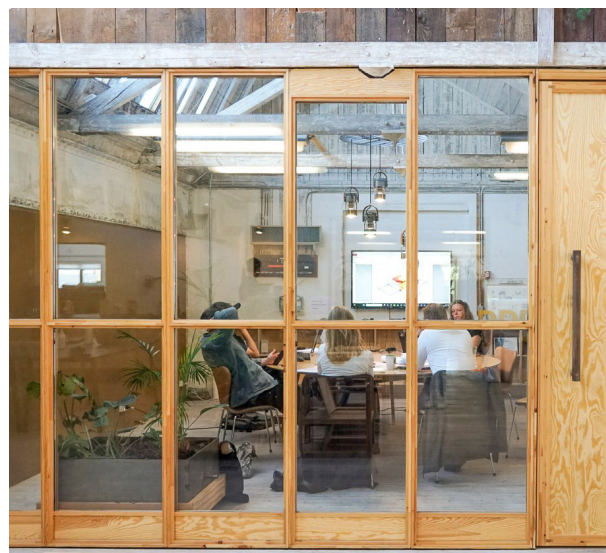
Tystø vægssystem af genbrugstræ og genbrugsglas. Foto: a:gain
