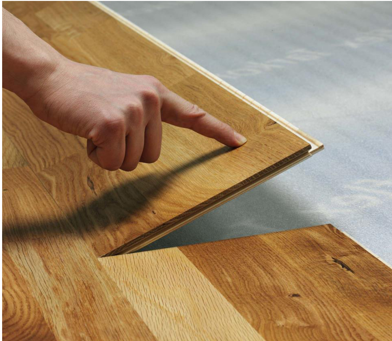
Tarketts trægulve med 2-lock-låsesystem, som gør dem nemme at lægge.
