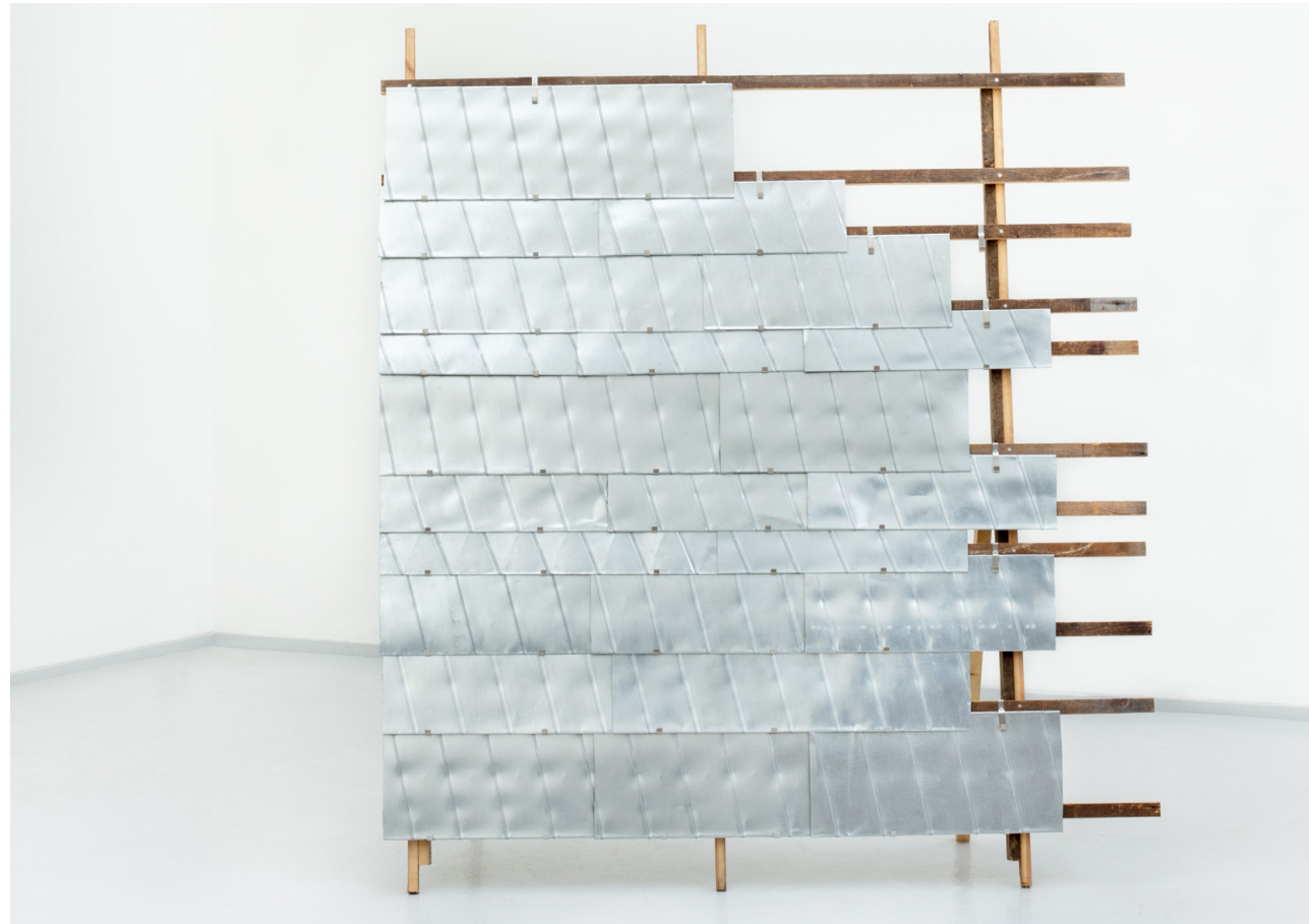
1:1 prototype af facadebeklædning lavet af sammenpressede spirorør.
